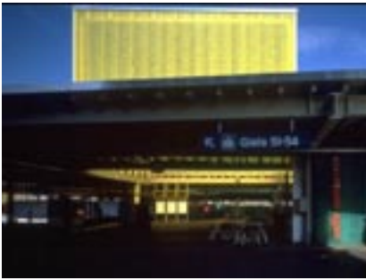
Provisorium Bahnhof Sihlpost, Zürich, 2003
