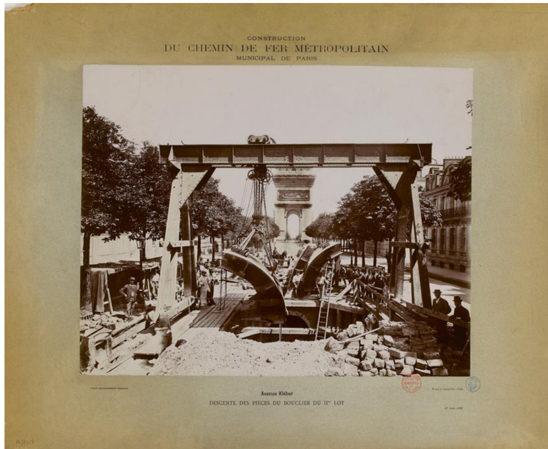
Anonym (Union Photographique française): „Bau der Pariser Metro. Avenue Kléber. Absenken der Röhrensegmente, zweiter Bauabschnitt, 17. Juni 1899“, 1899
