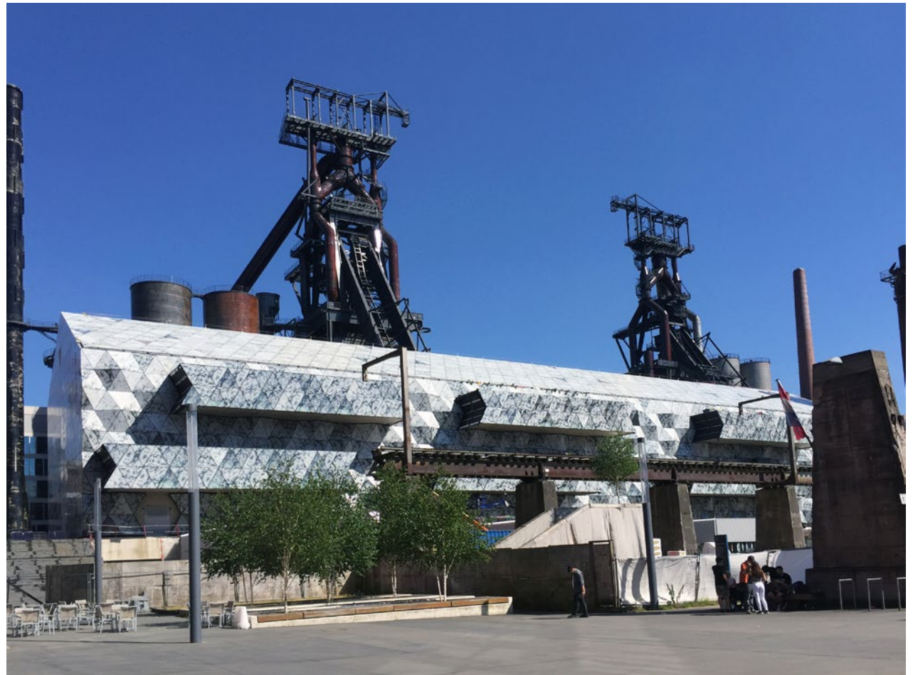
Die ehemalige Möllerei zu Füßen der Hochöfens wird bis Mitte 2018 zur Universitätsbibliothek umgebaut. Die polygonale Fassadenstruktur besteht aus lichtdurchlässigem Hightech-Kunststoff. Fotos: Valentiny hvp architects
