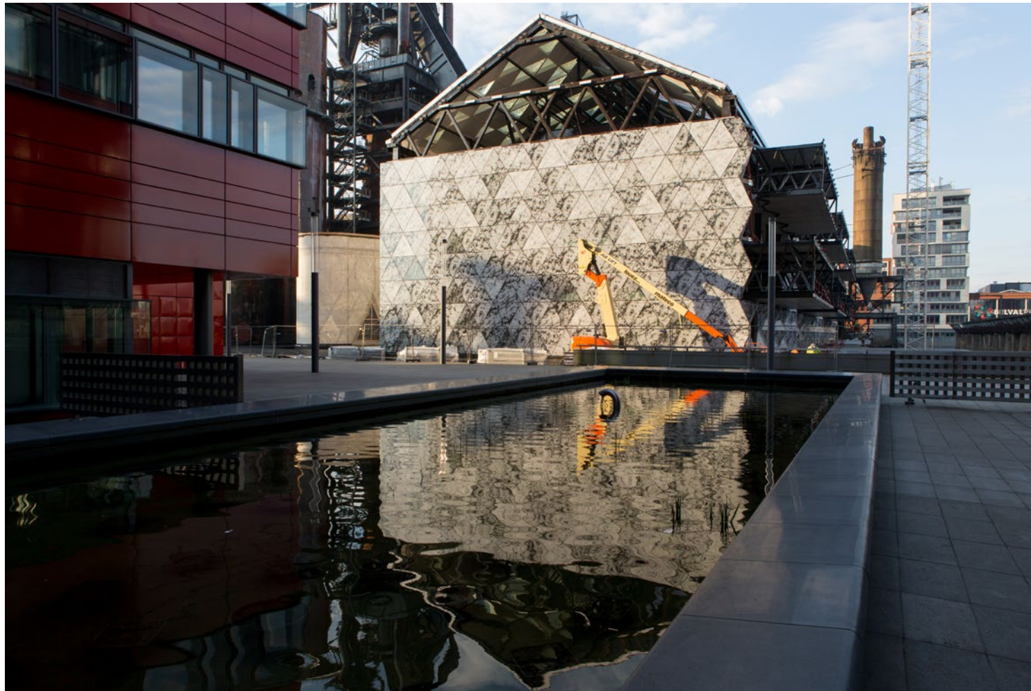
Arbeiten an der künftigen Bibliothek, die an der zentralen Nord-Süd-Achse Belvals liegt, im vergangenen Jahr. Foto: Universität Luxemburg / Michel Brumat
