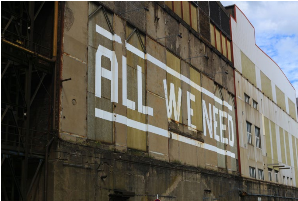
Im Rahmen des luxemburgischen Kulturhauptstadtjahres 2007 wurde die frühere Gebläsehalle als Galerie für die Ausstellung „All we need“ genutzt. Derzeit steht die riesige Halle leer. Die alten Gütergleise des Stahlwerks werden jetzt von den Zügen nach Luxemburg-Stadt befahren. Eine halbe Stunde dauert die Fahrt vom Bahnhof Belval-Universität. Nach Frankreich sind es nur zwei Minuten, die Grenze liegt direkt hinter dem Gebäude. Fotos: Katrin Groth
