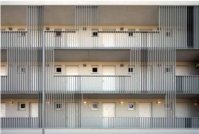
Studentenwohnheim Regensburg – Detailansicht Laubengänge
