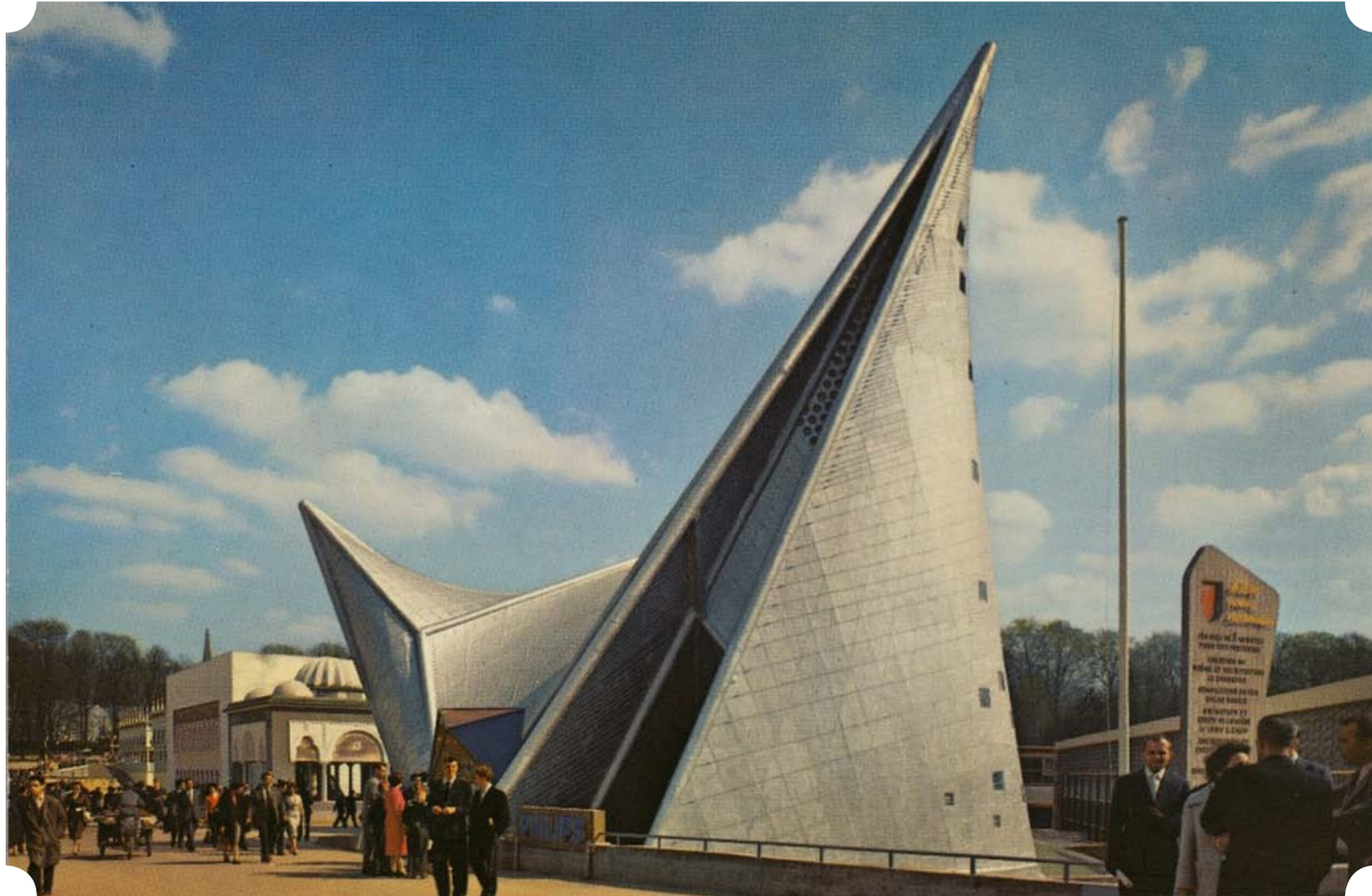
Den Philips-Pavillon für die Brüsseler Weltausstellung 1958 entwarfen Xenakis und Le Corbusier als dreidimensionalen Illusionsraum. Diaprojektoren, Filmvorführgeräte, Spiegeln und Lampen sorgten für ein intensives Raumerlebnis im Inneren der mastgestützten Membrankonstruktion. Edgar Varèse komponierte die Musik für das Poème électronique . (Iannis Xenakis Philips-Pavillon, ca. 1958. Postkarte 10 x 15 cm, Iannis Xenakis Archives, Bibliothèque nationale de France, Paris)
